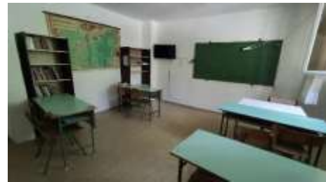
18. kép. A csoport tanulószobája felújítandó, elhasznált bútorokkal
